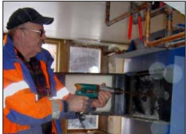
“Borrmaskinen är en bra hjälp när jag sotar ur konvektorerna”, visar Pehr.
